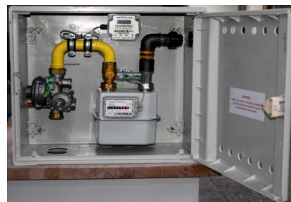
Figura 3. Echipament montat retrofit în interiorul cofretului de tip post reglare-măsurare
