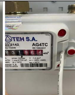
Figura 3. Echipament montat retrofit în interiorul cofretului de tip post reglare-măsurare
