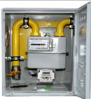
Figura 2. Echipament montat retrofit în interiorul cofretului de tip post măsurare
